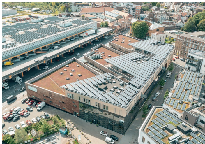
De pv-installatie op het dak van Greenbizz Brussels is goed voor 240 kWp. Via de energiegemeenschap wordt de opbrengst onder zo'n twintig bedrijven gedeeld.
