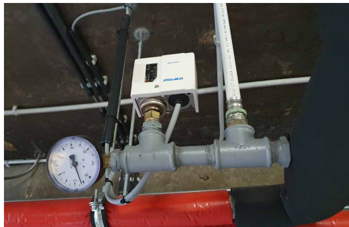
Analoge en digitale sensoren meten de (water)druk op een leiding.
