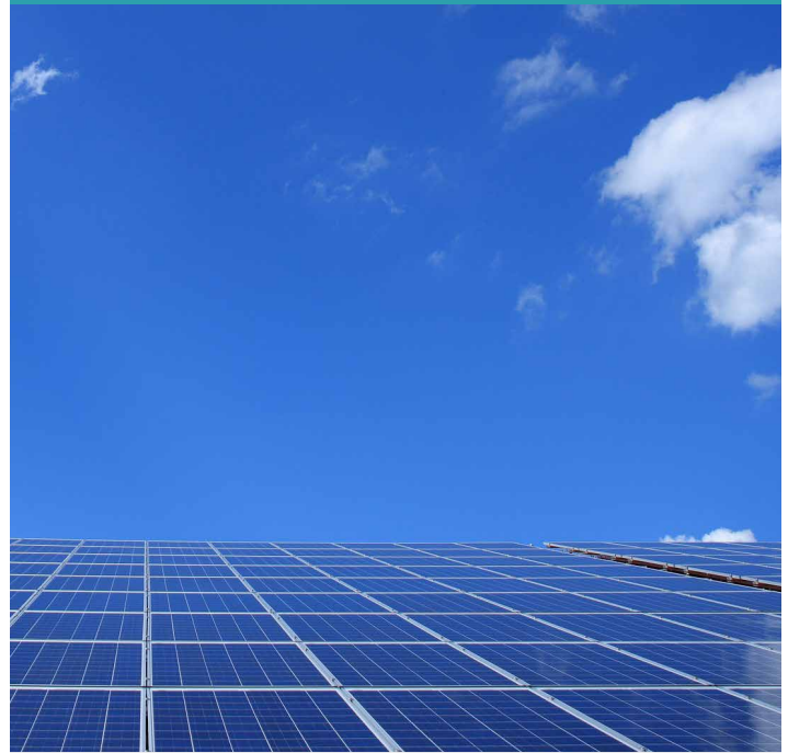
Elektrische wagens worden best opgeladen op het moment dat het gebouw zelf stroom kan produceren, bijvoorbeeld via de PV-panelen.
