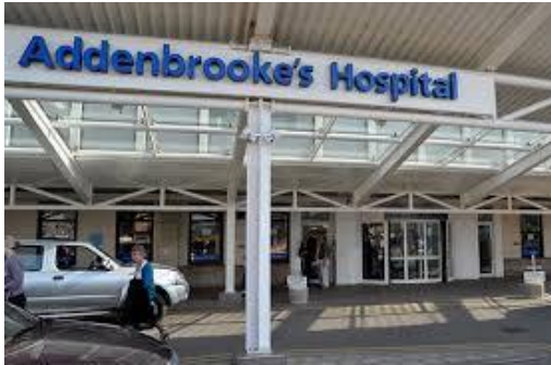
Addenbrookes Ziekenhuis, Cambridge, VK Trend BMS, Phoenix Valves en Gent Brandalarm
